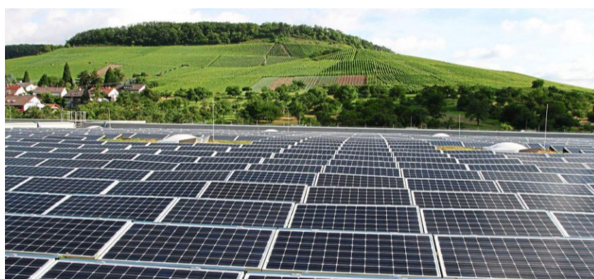
Ausgerichtet: Der Mineralbrunnen hat einen Solarpark mit 5 000 Modulen.
