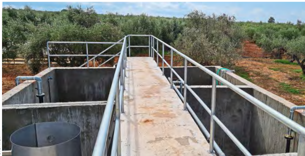
Im Bau: Das neue Klär-System kostet rund 300 000 Euro.
